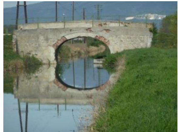
Historische Hauersteigbrücke in Sollenau
