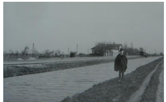
Höhe Station Zentralfriedhof der Aspangbahn
