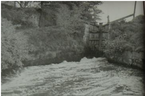
Schleuse 34 mit Schleusentoren, bei der Schulgasse, Kottingbrunn. Dieses letzte verbliebene Tor wurde 2014 entfernt
