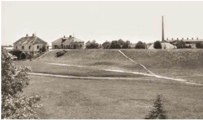
Kanaldamm bei der Unterführung der Ödenburgerstrasse
