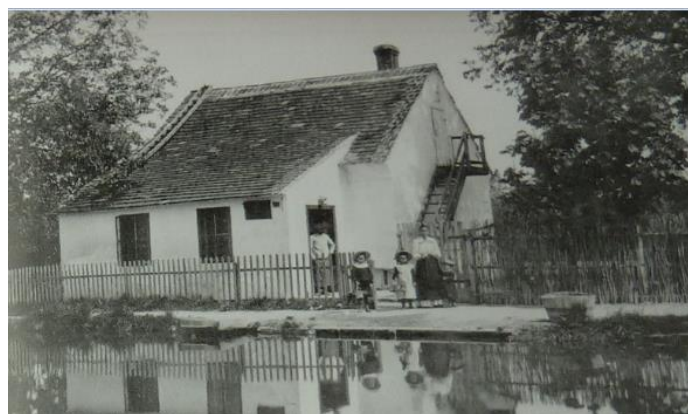
Kanalwärterhaus am östlichen Kopf des Leitha-Aquäduktes, Lichtenwörth
