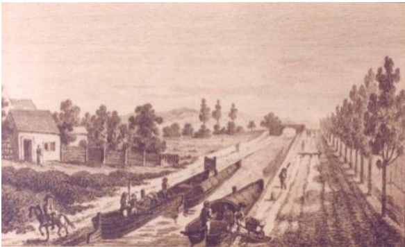
Kanalbetrieb zwischen Triangel und Schelmenbrücke, Wiener Neustadt
