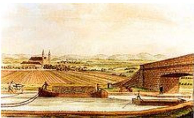
Kanalbetrieb bei Maria Lanzendorf
