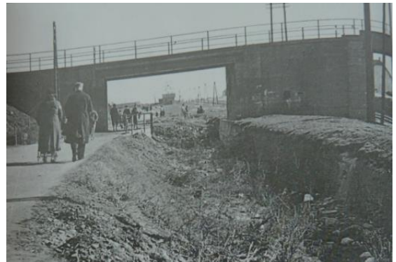
Leerer Kanal bei Ostbahnbrücke, Hasenleiten
