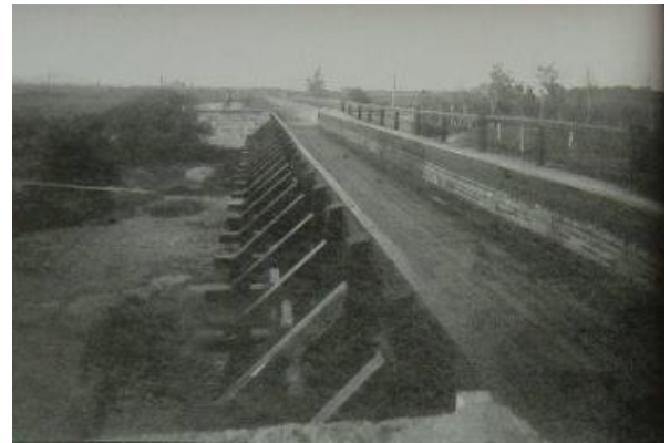
Schleiferbach-Trog, im Bau befindlich, 1909, Triesting-Hochwassergraben Schönau
