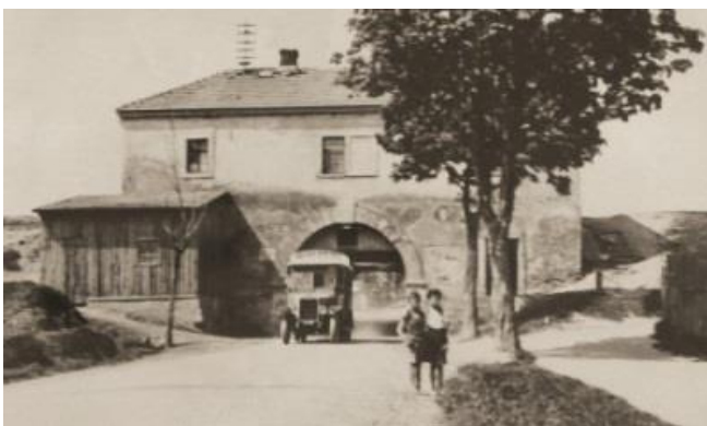
Trog über die Ödenburger Straße, es war dies die einzige Strassenunterführung des Kanals, Leopoldsdorf
