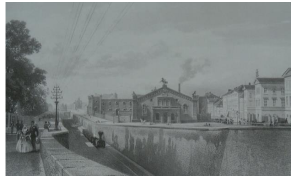
Verbindungsbahn auf der Trasse des Kanals, Rechte Bahngasse
