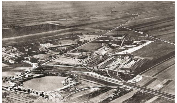
Kanalareal in Leopoldsdorf, links unten: Unterführung der Ödenburgerstrasse
