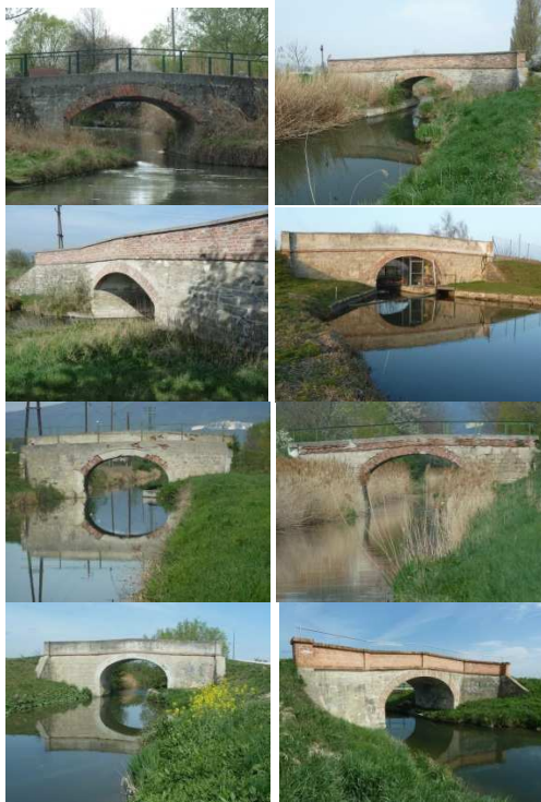
Die acht noch weitgehend erhaltenen Brücken am Kanal, im klassizistischen Baustil um 1800, stellen das älteste Brückenensemble Österreichs dar.
