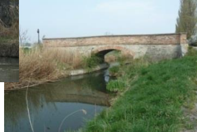
Weingarten Brücke (Tribuswinkler Viehtriebbrücke)
