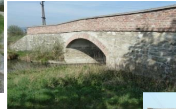
Rote Brücke (Haidbrücke)
