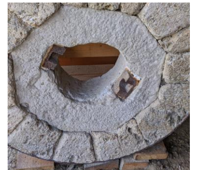
„Franzosenstein“ auf Natur-Sandsteinträger Steinbrecherhaus, Perg OÖ
