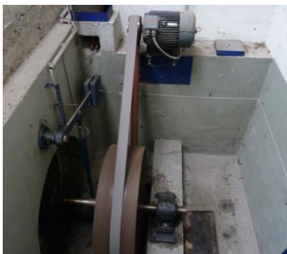
Francisturbine mit Generator
